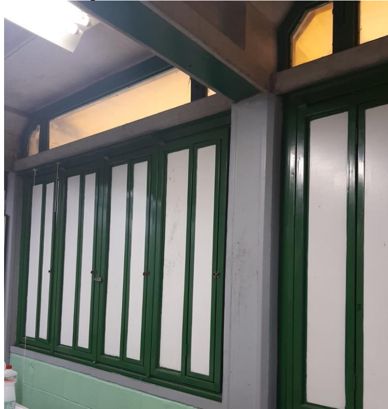
Figura 4 – Janelas das salas de aula
