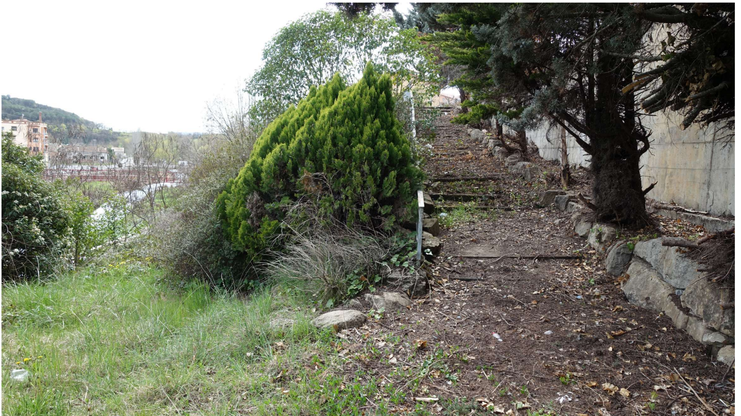
Escala rampa que connecta la part alta del jardí amb el nivell inferior a l'altre banda de la parcel·la, al costat de la zona porticada.
