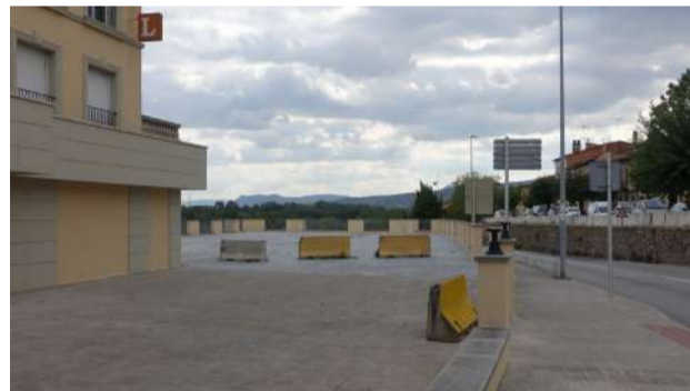
Imatge 2. Cota +521.92m s. n. m. Accés al mirador de les Serrasses que es ahora la coberta de l'edifici sala on intervindrem.
