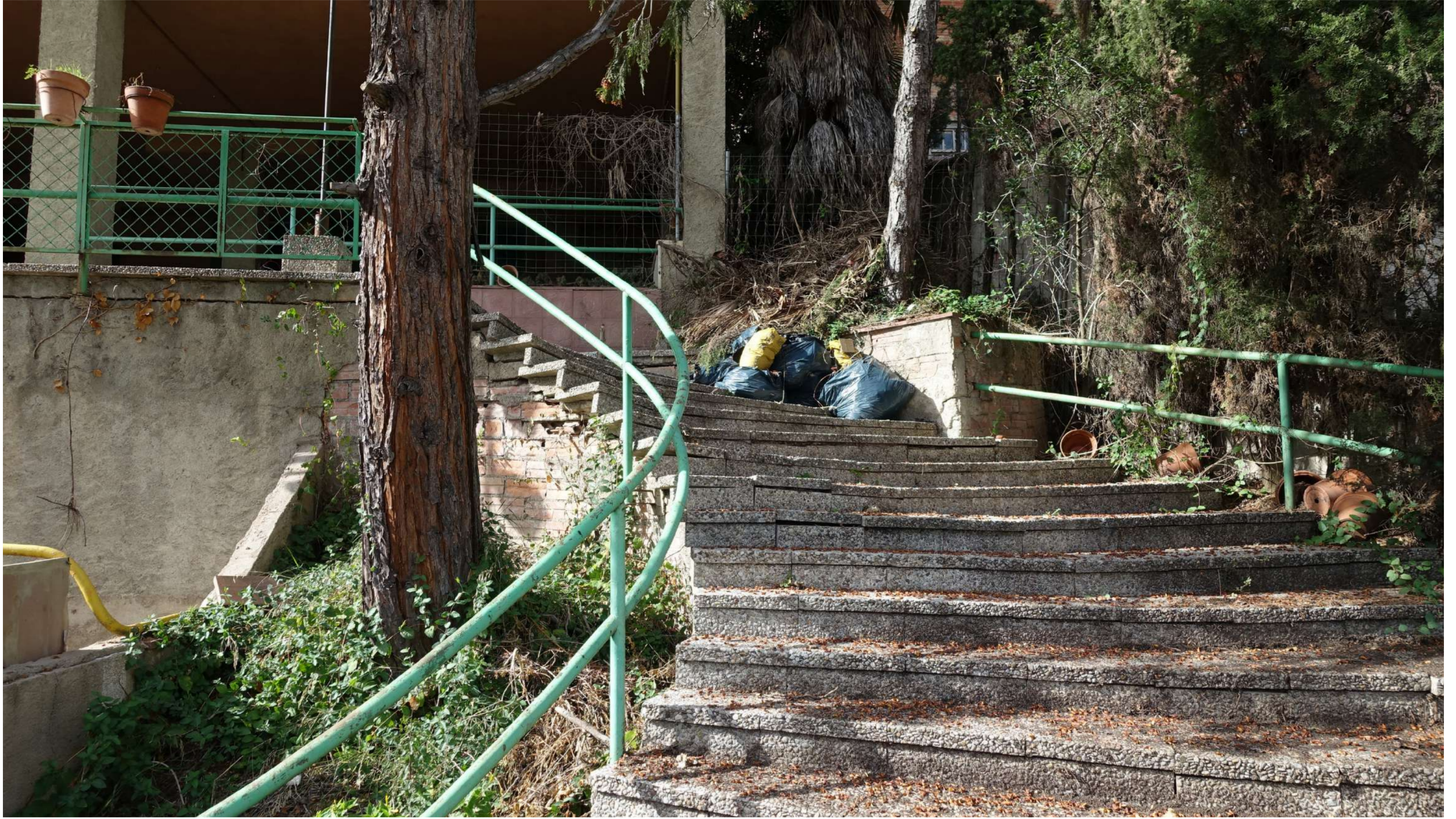
Escala que connecta la part alta del jardí amb el nivell inferior al límit de la parcel·la, enfront a l'edifici hotel.
