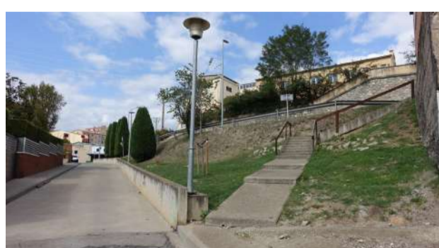
Imatge 4. Cota +511.10m s. n. m. Escales que connecten la Carretera de Conanglèl amb el Camí del Canal.
