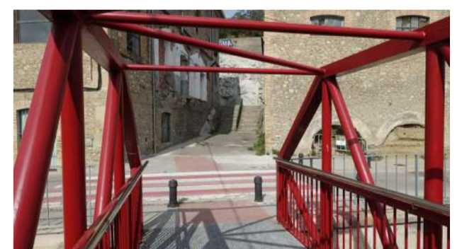
Imatge 9. Cota +500.50m s. n. m. Des del Pont del Carrer Sant Josep mirant cap a les escales que ens comuniquen amb el Camí del Canal.
