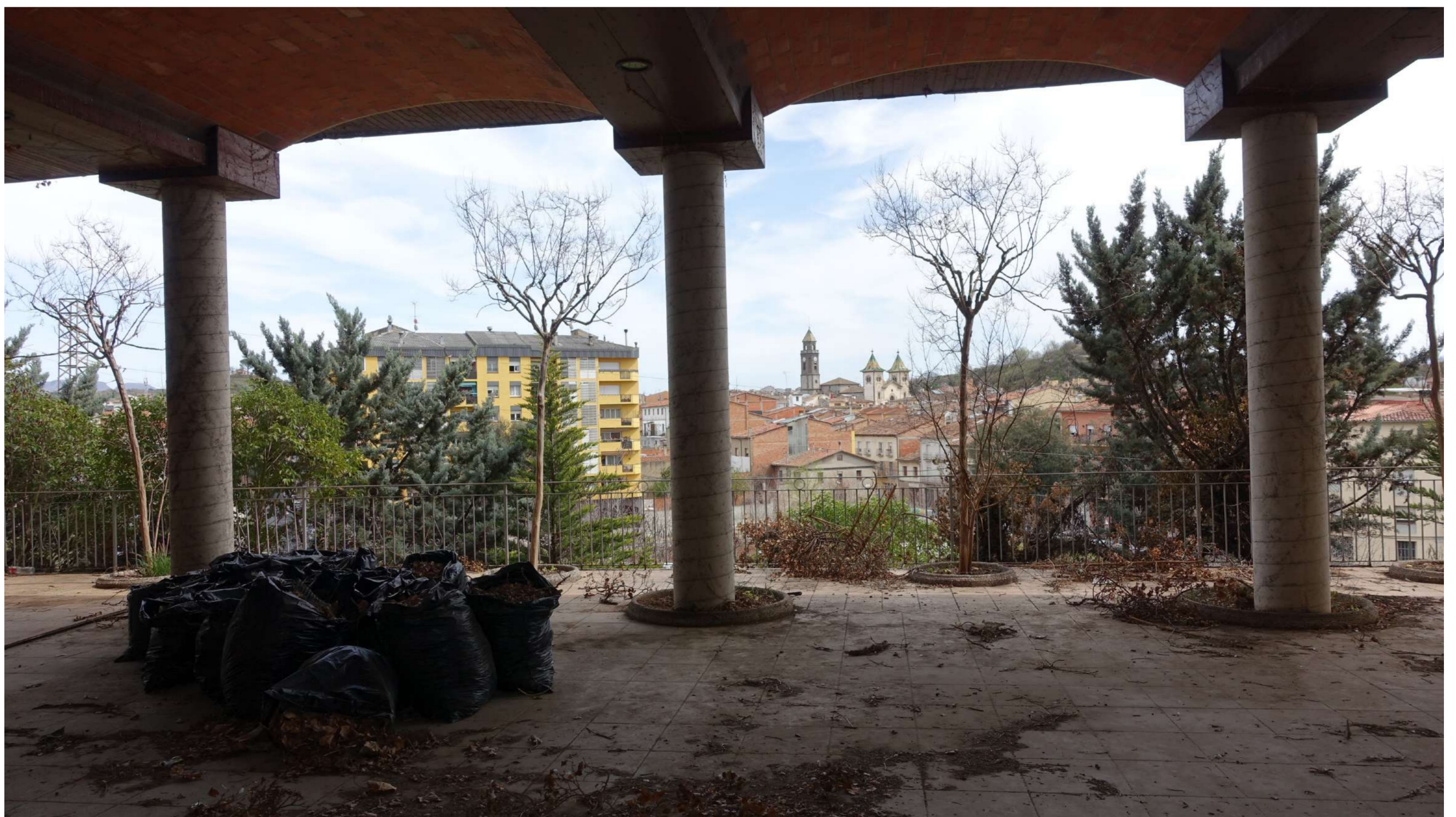
Vista de la població de Torelló sota la Sala de convencions, en la zona porticada del jardí.
