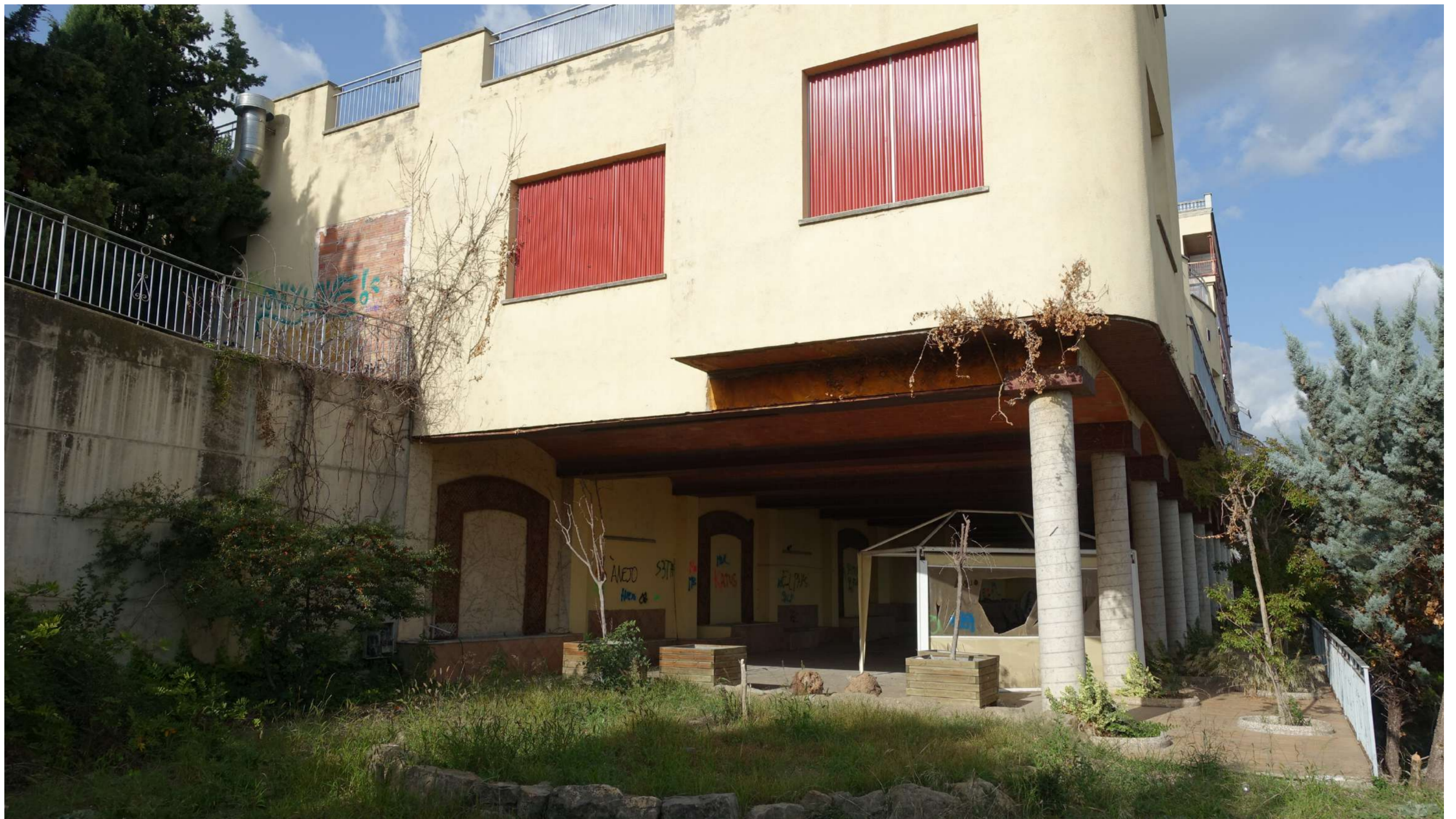
Vista de la façana sud-oest de la Sala de convencions des de la part alta del jardí, fora de la zona porticada de l'edifici.
