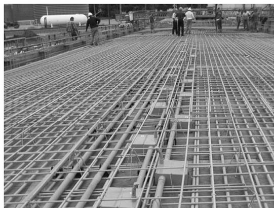
Figura 3.3.5: Conductos de PVC de cloruro de polivinilo y cajas de derivación preposicionadas en el tablero del puente de hormigón armado [78].
