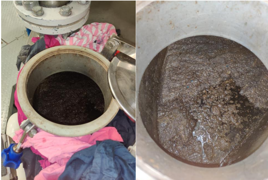
Figura 28. Interior del polishing filter durante su proceso de lavado
