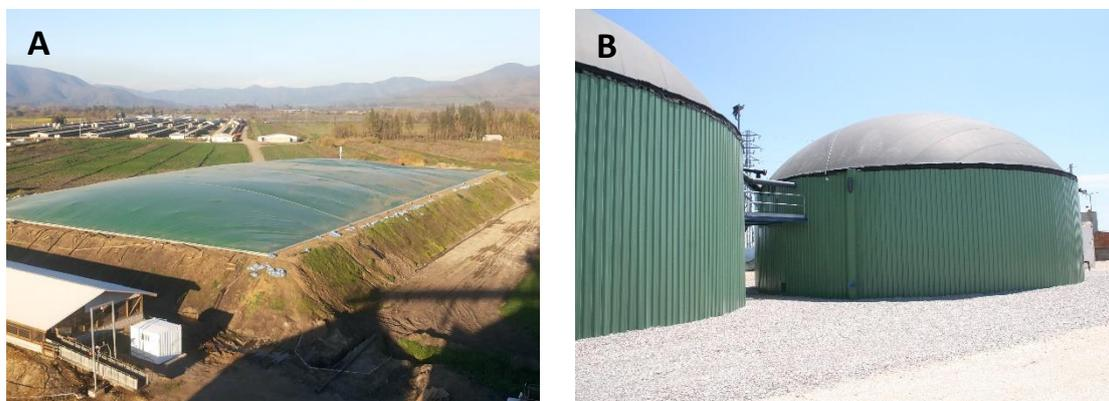
Figura 3. Digestores usuales en el sector ganadero: A) laguna anaerobia cubierta con recuperación del gas (gentileza de Agrícola AASA, Chile); B) reactor anaerobio de mezcla completa con codigestión en una granja de cerdos (gentileza de Ecobiogas, Vila-sana, Lleida).
