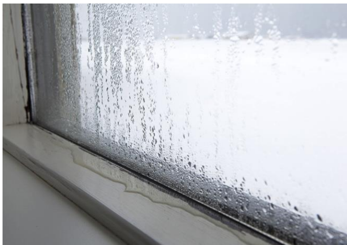
Figura 6 Condensación Ventana [9]
