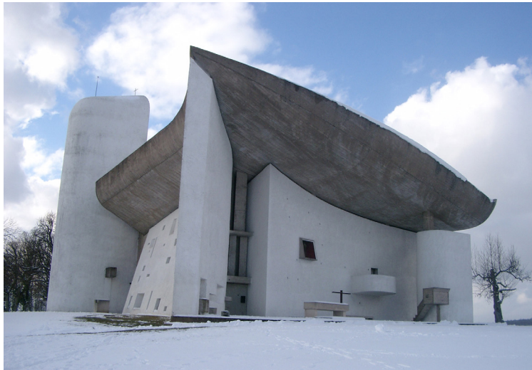
Fig. 2. Le Corbusier Notre Dame du Haut de Ronchamp [1950-1955] Exterior view / Vista desde el exterior
