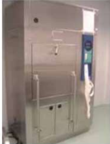
Figure 10. Sterilization substation (Bloque quirúrgico. Estándares y recomendaciones)
