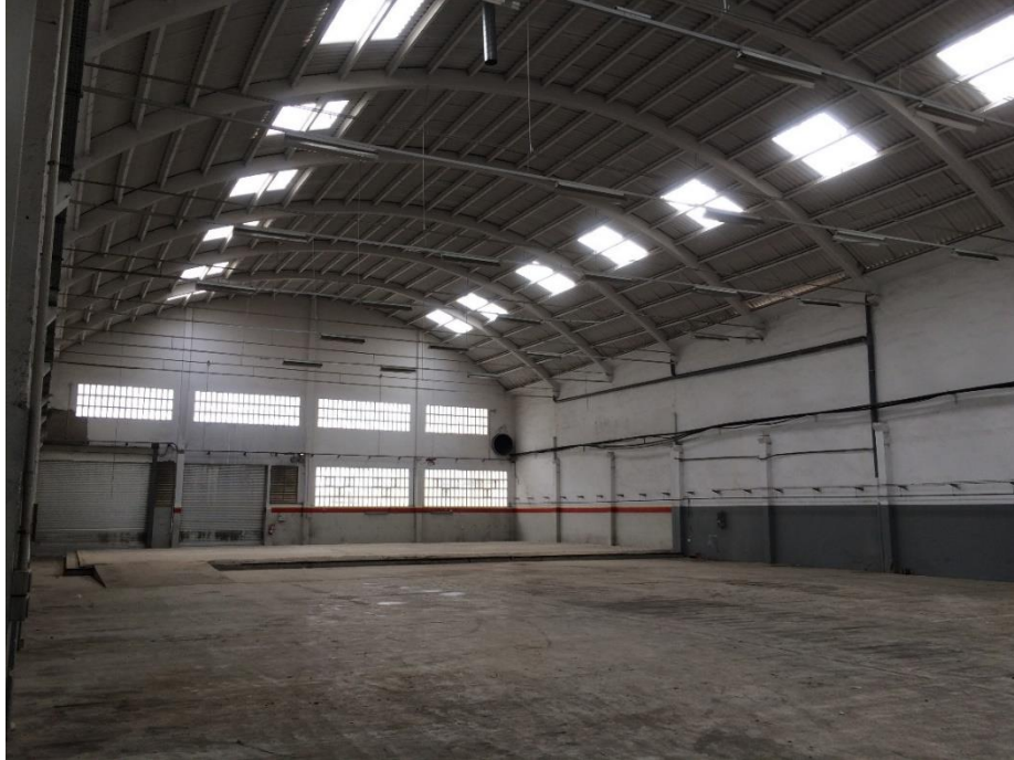
Figura 14: Cubierta principal antes del inicio del proyecto (Fuente Propia)
