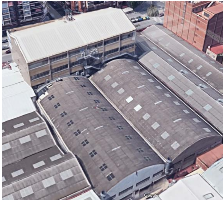
Figura 15: Cubierta principal antes del inicio del proyecto. Vista aérea (Google Maps 2022).
