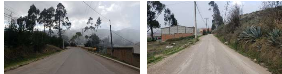
Vía de asfalto
