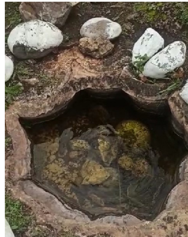
Imagen 71: Tramo vial 3 - Pozo descuidado Fuente: Autoras, 2021
