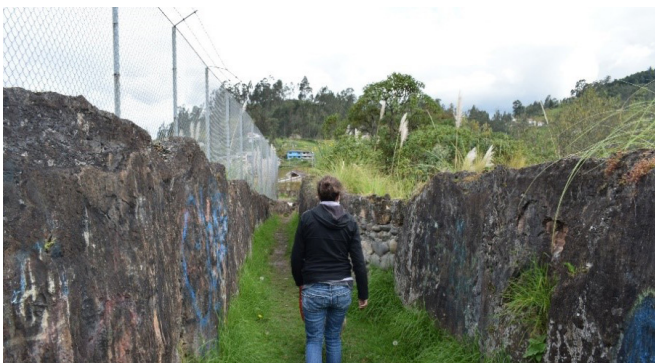
Imagen 68: Tramo vial 3 - túnel de roca Fuente: Autoras, 2021
