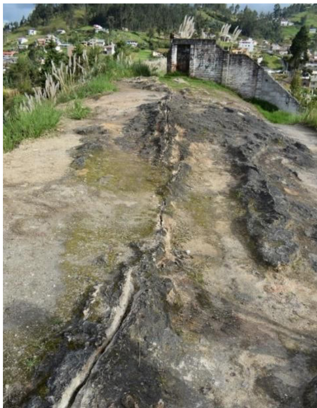
Imagen 61: Tramo vial 2 obstruido por construcción Fuente: Autoras, 2021
