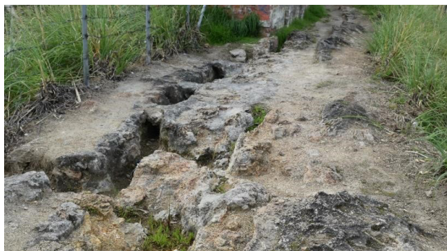
Imagen 70: Tramo vial 3 - canales donde circulaba agua Fuente: Autoras, 2021
