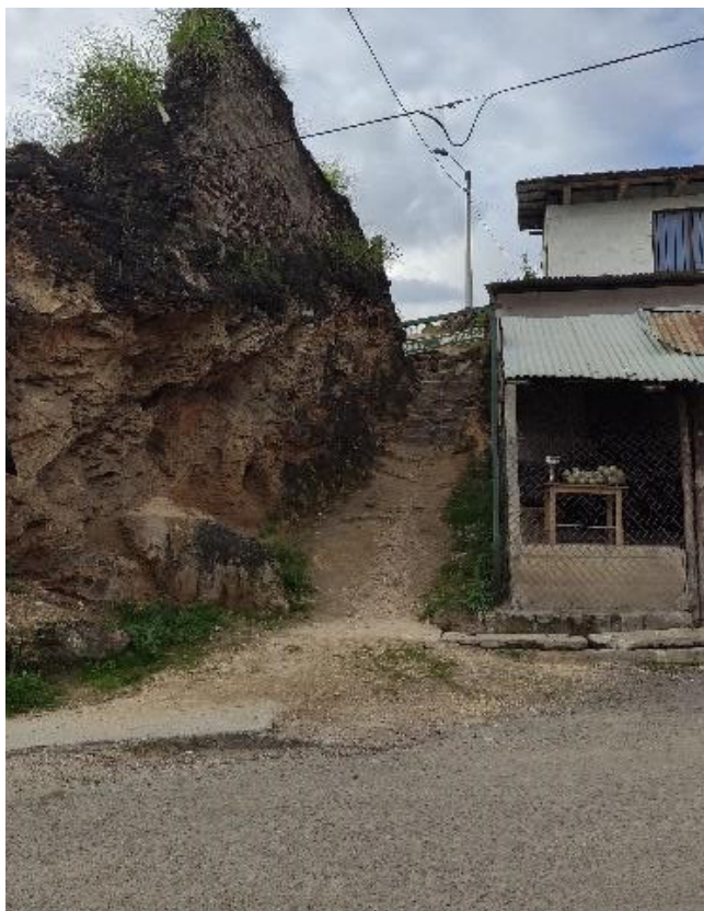
Imagen 58: Tramo vial 1 - Acceso 3 Fuente: Autoras, 2021
