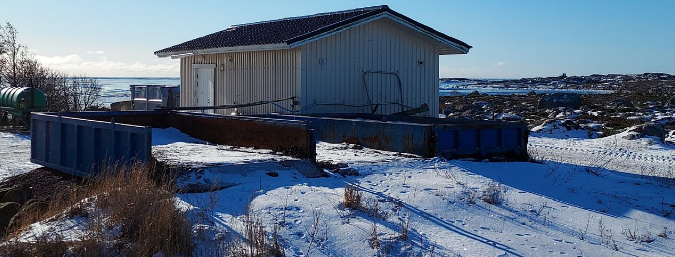
Reningsverket för avfallsvatten på Utö. Här har lådorna med slamkompost just tömts. Foto: Hanna Kovanen
