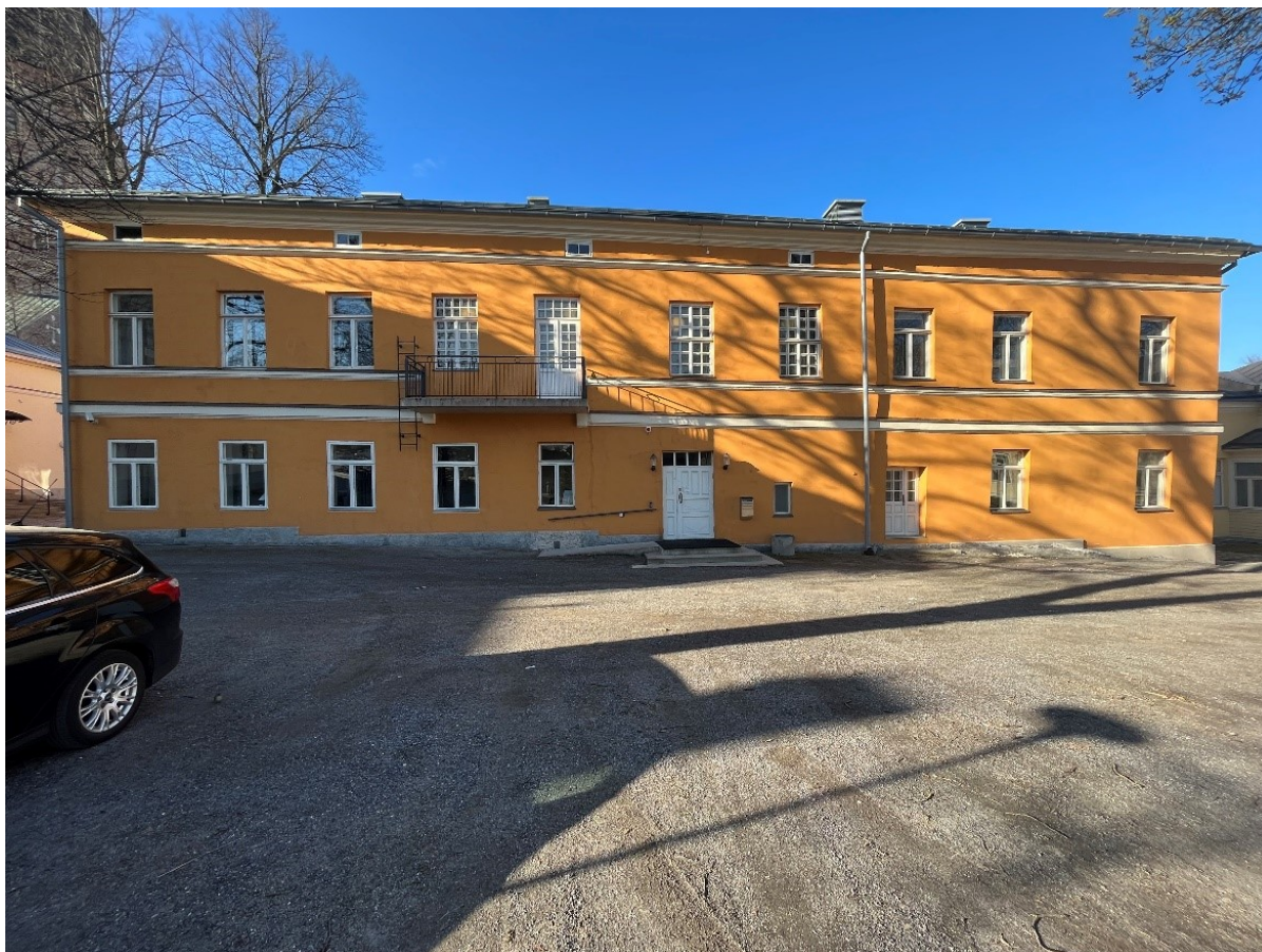
Figur 4. Åhuset vid Gezeliugatan 2 blev färdigt år 1831. Huset har med tiden satt sig och det syns speciellt i stengrunden.
