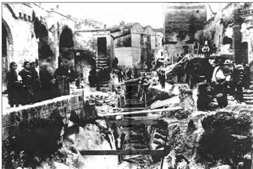
Foto 1 - Lavori di sistemazione del Fosso Caveoso a Matera
