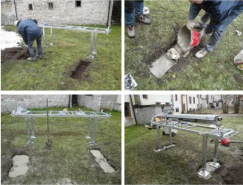
Figura 8.25 Fasi della materializzazione della postazione di misura.
