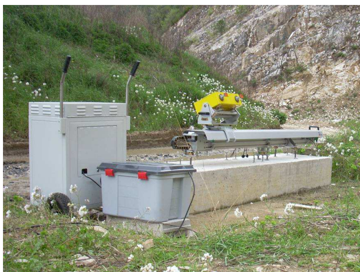
Figura 4.14 Installazione IBIS-L di fronte alla frana (IDS Corporation)
