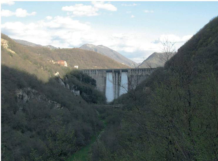
Fig. 4. La grande diga del Turano, del tipo ad arco e a gravità ordinaria in calcestruzzo, alta al coronamento 73 metri. Vista da N (Posticciola).
