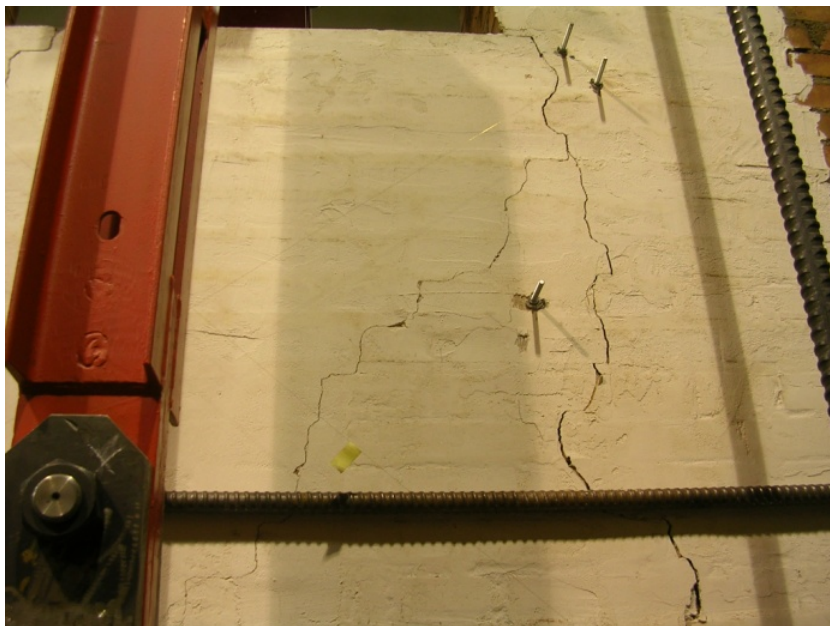
FIGURA 29: PRIMA FESSURA COMPARSA DURANTE LA PROVA MS1R
