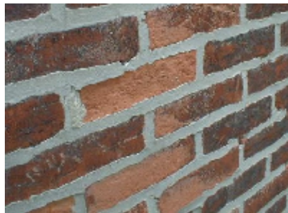
FIGURA 16: MURATURA STORICA IN LATERIZIO PIENO
