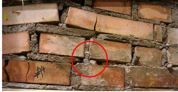
FIGURA 4: LUOGO DEL PRELIEVO DEL PRIMO CAMPIONE DI MALTA, APPENA AL DI SOPRA DELLA TRAVE IN LEGNO
