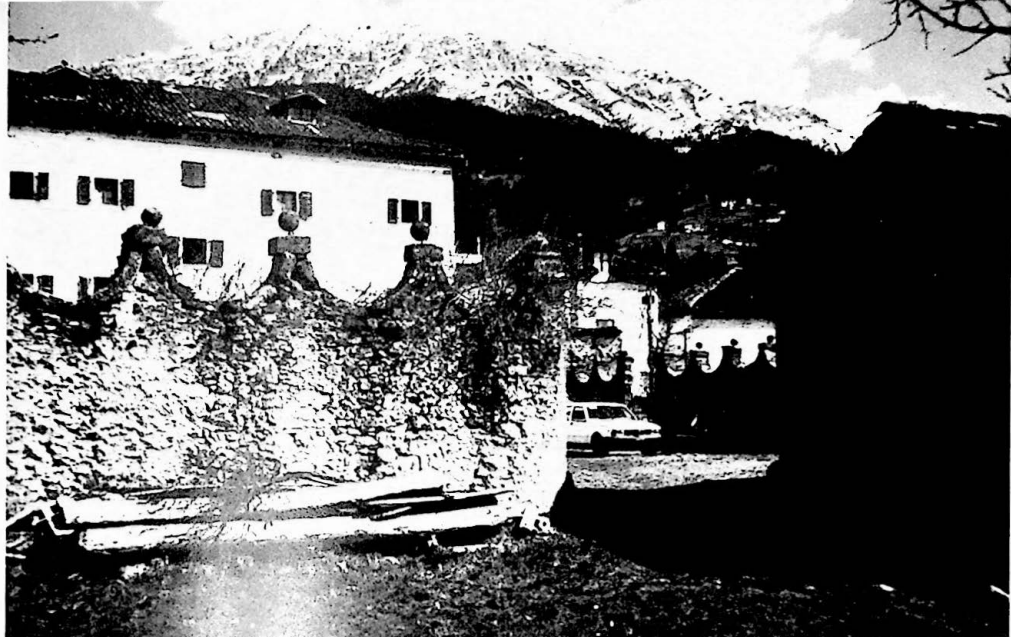
Fig. 7 Casa Calio, oggi Valesio-Calice a Villa Fuori (fraz. di Paularo)
