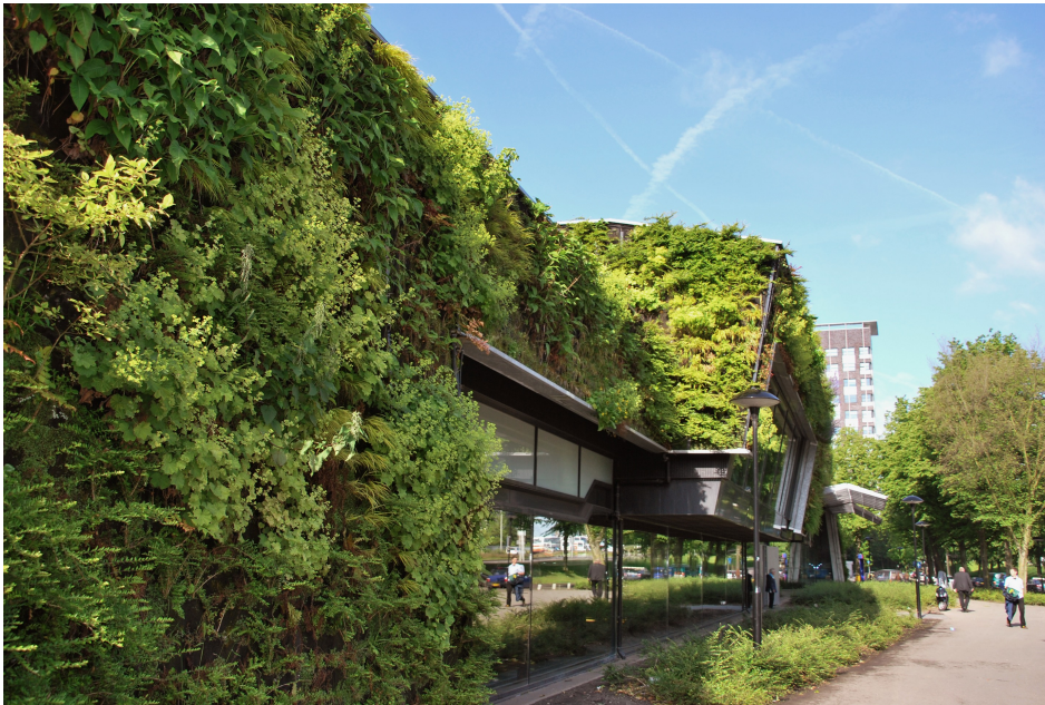
Figura 1.1 – Verde verticale e copertura verde nell’edificio sportivo polifunzionale Sportplaza Mercator a Amsterdam, progetto architettonico studio Venhoeven CS, Amsterdam (NL); progetto del verde studio Copijn, Utrecht (NL) (fonte artdco.net//, foto Luuk Kramer).
