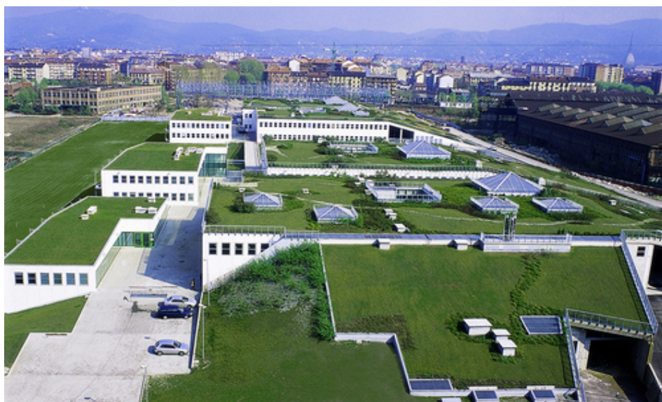
Figura 1.10 – Environment Park, Torino, progetto architettonico E. Ambasz, B. Camerana, G. Durbiano (fonte www.greenroofs.com/projects/ ). È il risultato della riqualificazione di un precedente brownfield esteso per 150 ettari avvenuta tra il 1996 ed il 1999.
