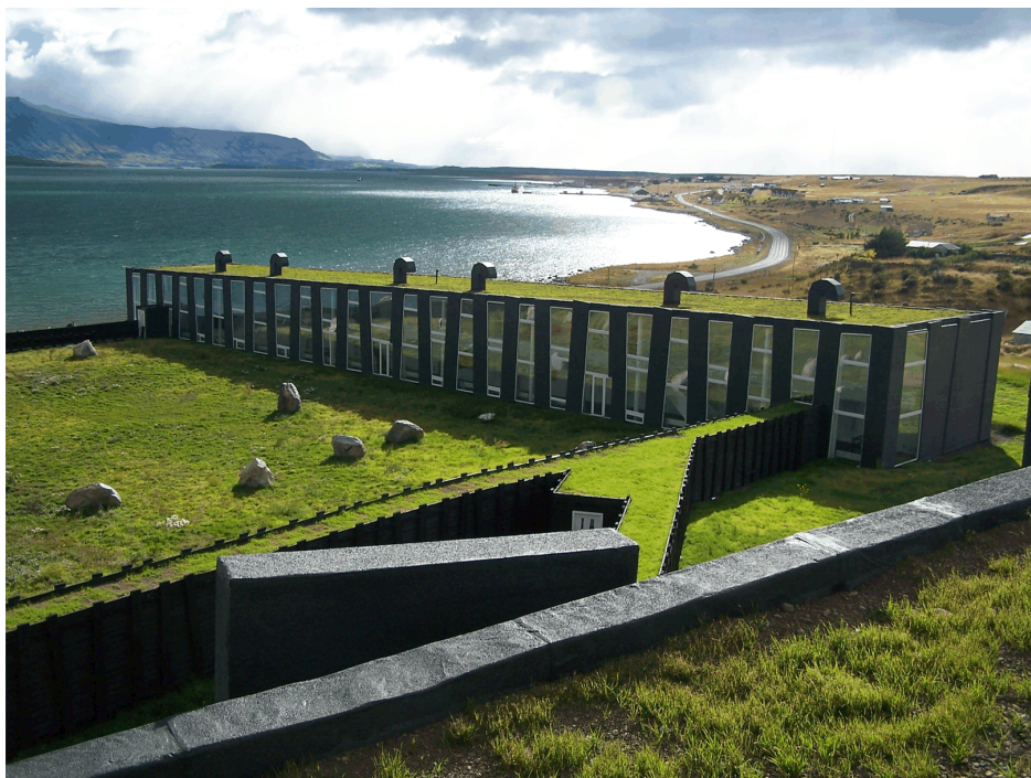
Figura 1.11 – Remota Hotel, Puerto Natales (RCH), progetto architettonico arch. G. del Sol, 2005 (fonte greenroofs.com/projects/ ). Il concept dell'edificio, che ospita 72 camere da letto, ha considerato come primo obiettivo il contenimento dei consumi energetici: è stato privilegiato l'orientamento dei volumi in modo da favorire l'accumulazione passiva dell'energia solare. La copertura dell'edificio è stata realizzata con ghiaia e erbe tappezzanti del luogo: la giacitura dell'elemento è duplice, 14% in corrispondenza della reception dell'hotel e 7% nel volume destinato alle camere.
