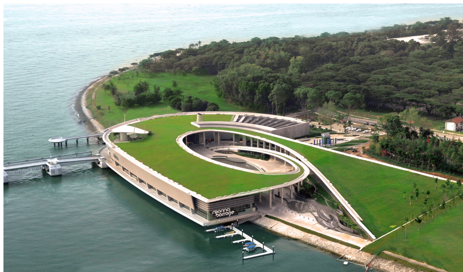
Figura 1.14 – Marina Barrage, Singapore (SG), progetto architettonico Architects Team 3 Pte Ltd, 2008 (fonte www.pub.gov.sg/marina/ ). Il mantenimento di condizioni di comfort nell'edificio è assicurato dalla copertura verde – che mimetizza l'edificio nel contesto naturale e permette lo svolgimento di attività all'aperto – e da serramenti ad elevata protezione solare. L'impianto di irrigazione è collegato a sensori di pioggia per la sua disattivazione in presenza di precipitazioni.
