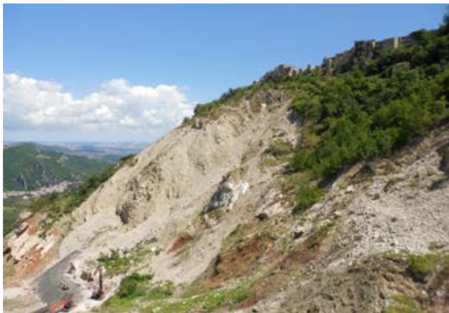
FIGURA 8 – La frana di Montebello sul Sangro in fase di consolidamento. A monte, l'antico borgo di Buonanotte oramai abbandonato. Fotografia dell'autore del luglio 2019
