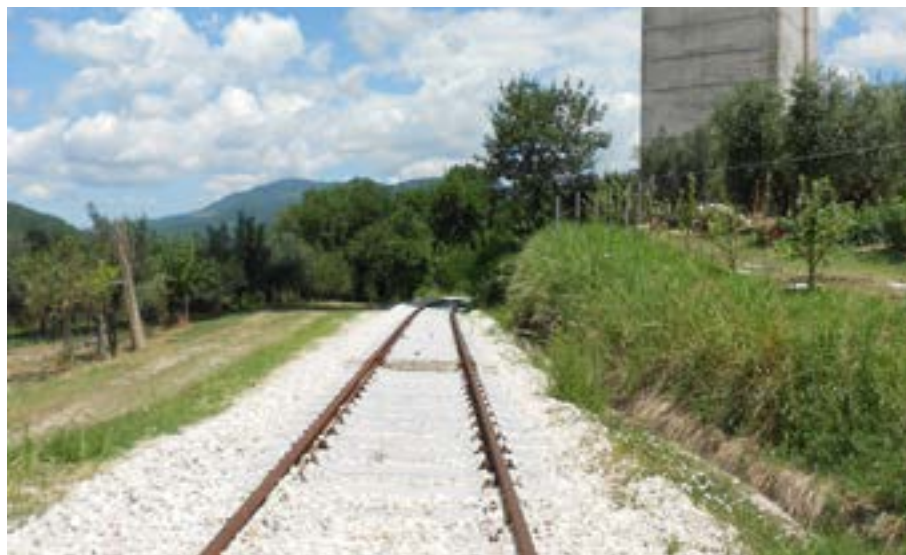
FIGURA 77 – I binari della Ferrovia Sangritana, nel punto in cui si incrociano con il viadotto della S.S. 652 "Fondo Valle Sangro", di cui si può notare anche la base di un pilone sulla destra. Fotografia dell'autore del luglio 2019
