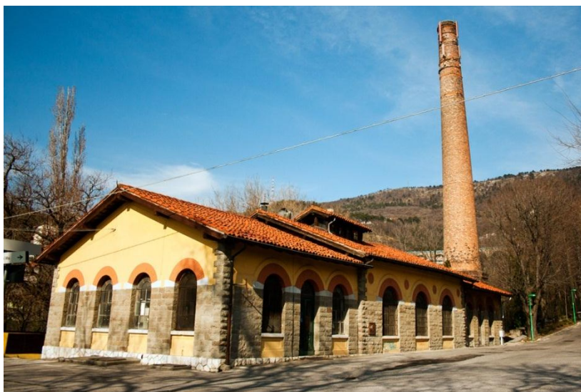
Figura 2.2 – La centrale termica del comprensorio ex-OPP
