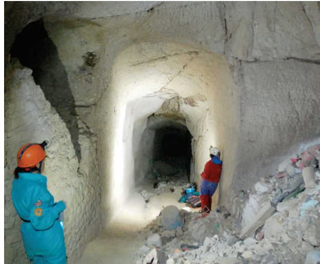
Fig. 5 La sezione della galleria (foto degli autori) Fig. 5 The tunnel cross-section (photo by the authors)
