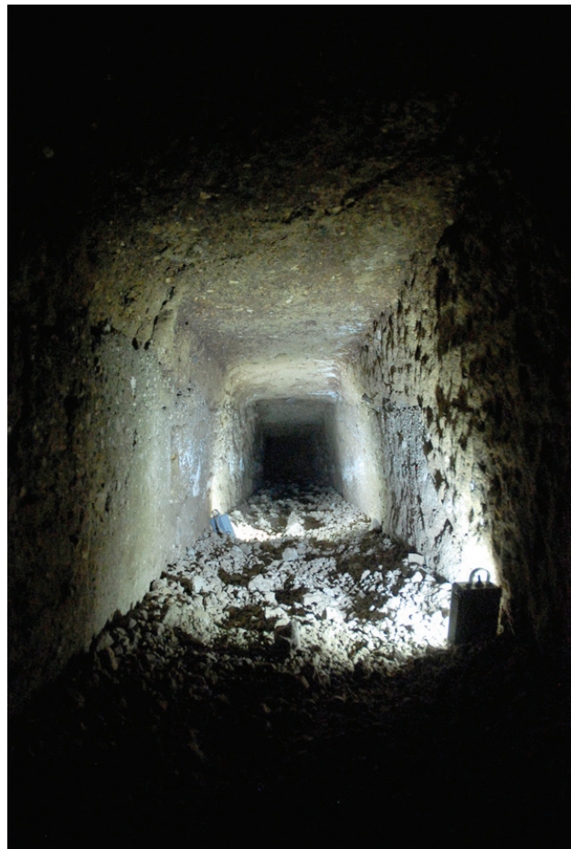
Fig 7 Lo speco dell'acquedotto (foto degli autori) Fig. 7 The aqueduct cross-section (photo by the authors)
