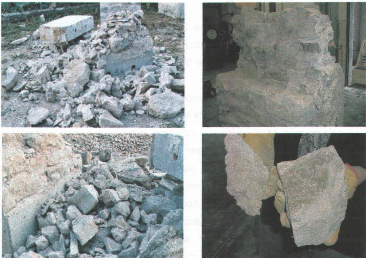
Fig. 92: Inadagine visiva su un muro non consolidato (a) ed un muro iniettato (b).
