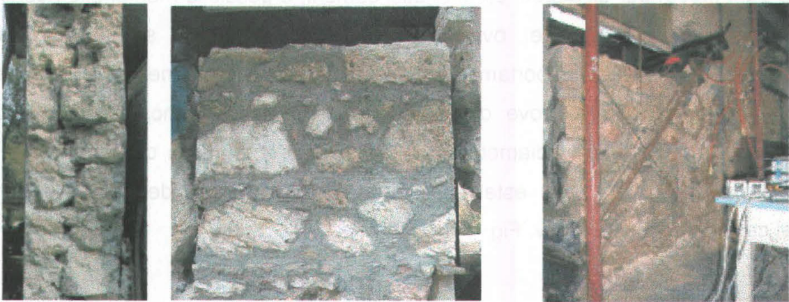
Fig. 36: Intervento di ristilatura+iniezione su un muro in pietra.
