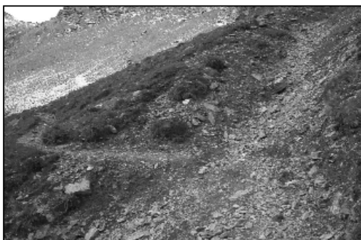
FIGURA 3 - Tratto del sentiero n. 20 (Goldseeweg) tra il Rifugio Garibaldi e il Rifugio Forcola (valle di Trafoi) interrotto per erosione lineare dovuta alle acque di precipitazione meteorica. L'asportazione di parte del sentiero rende difficoltoso l'attraversamento del solco. (Foto A. Carton, 14 Luglio 2004).
