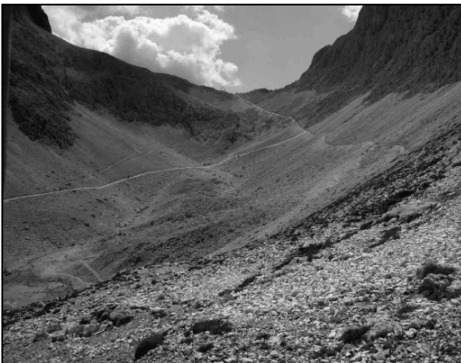
FIGURA 12B - Tratto di sentiero con fondo detritico orizzontale, inciso su versante che permette il passaggio contemporaneo di due persone. Sentiero 542 s SAT tra il Rifugio Re Alberto I ed il Passo Sattner (Catinaccio d'Antermoia, Dolomiti). A destra il simbolo corrispondente. (Foto A. Carton, 8 agosto 2003).
