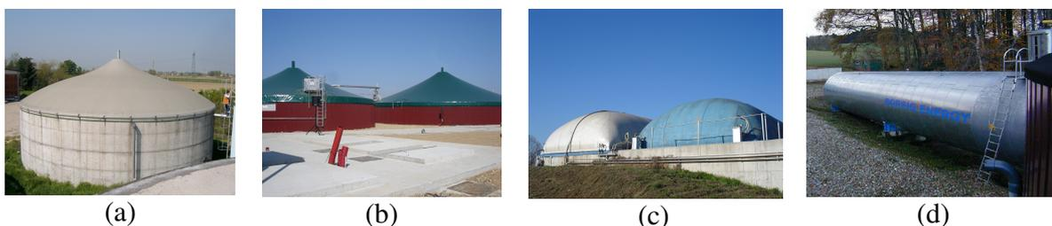
Figura n.80: Tipologie di digestori “*a umido*”: verticali a miscelazione completa (a), (b), a flusso orizzontale (c), (d).
