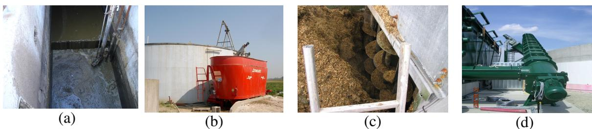
Figura n.79: Sistemi di alimentazione del digestore: pozzetto di pompaggio liquami (a), dosatore di solidi con tritatore (b), coclee verticali (c); tramogge (d)
