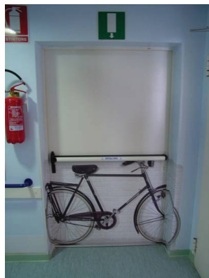
Foto 9 e 10: porta tagliafuoco pellicolata - prima e dopo (da sinistra a destra)
