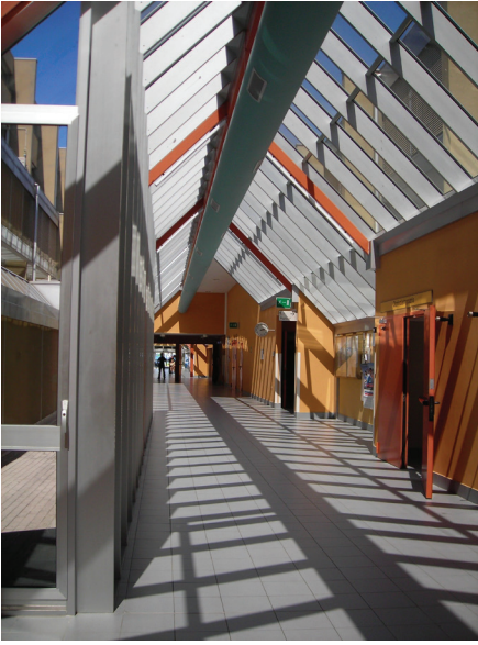
Foto 1: ingresso – disorientamento spaziale
