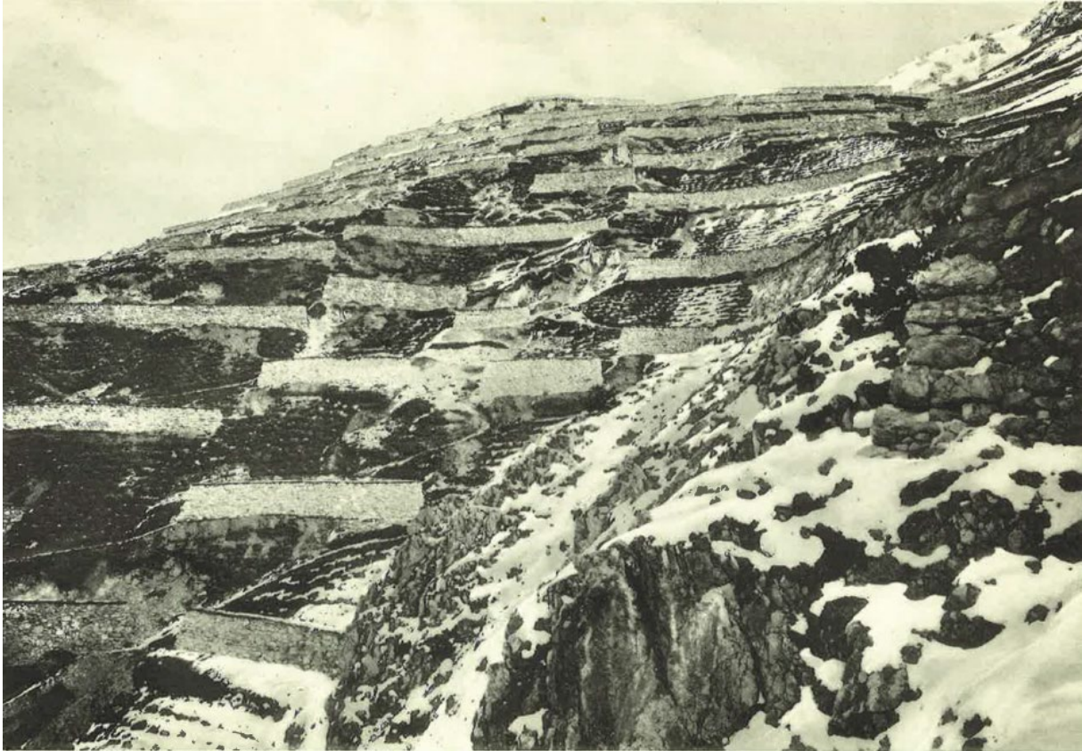
Abb. 13: Die fertiggestellten Mauerarbeiten im oberen Bereich der Muot-Verbauung. Quelle: Coaz 1910: Abb. XXIV.
