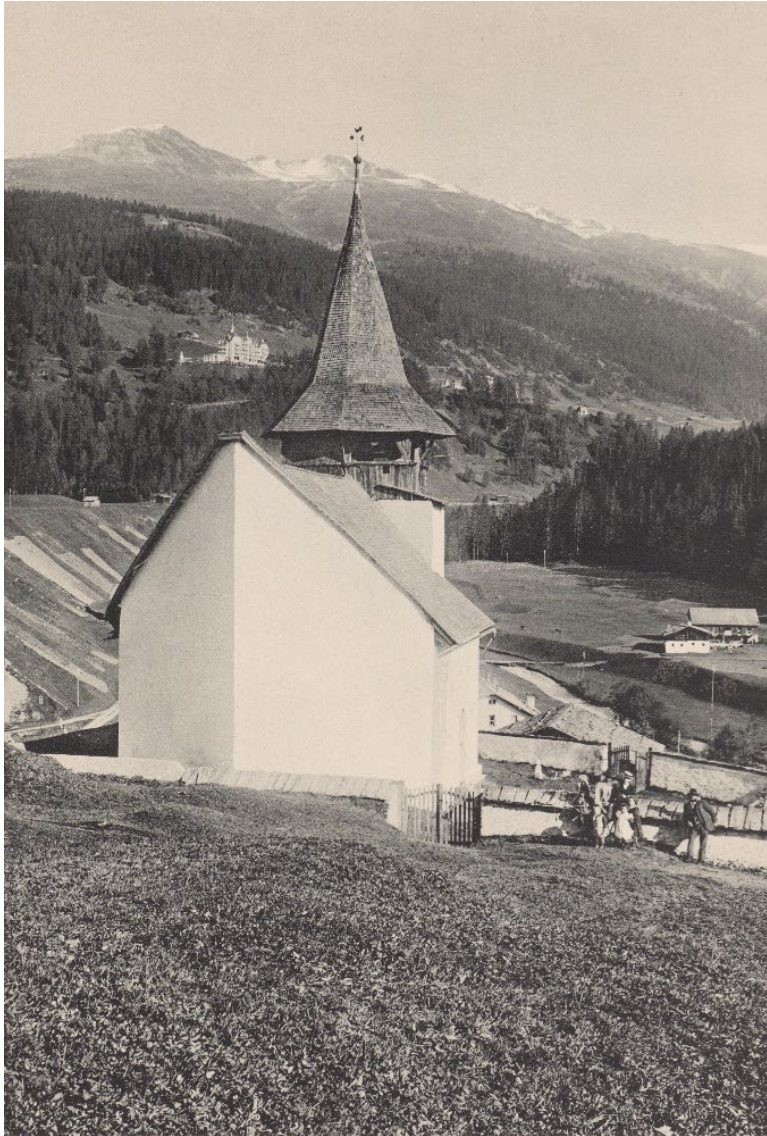
Abb. 1: Fotografie des Spaltkeils von Davos-Frauenkirch, ca. 1909. Quelle: Coaz 1910: Abb. XIX.
