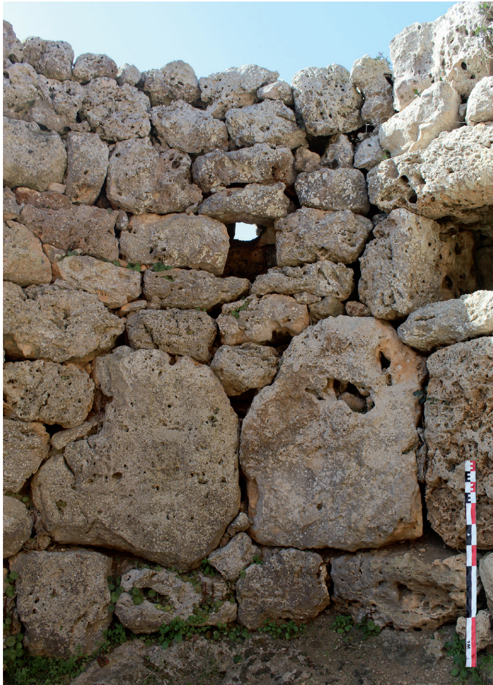
Figura 6. Vista interior de la abertura en la fachada del edificio.
