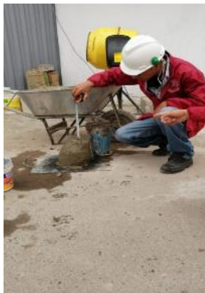
Figura 17. Prueba del Slump
