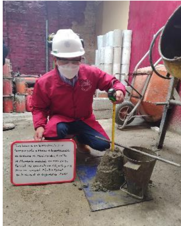
Figura 70. Prueba del Slump
