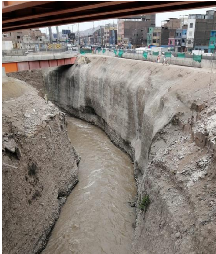
Figura 15. Situación actual del tramo de estudio. Fuente: Fotografía propia.
