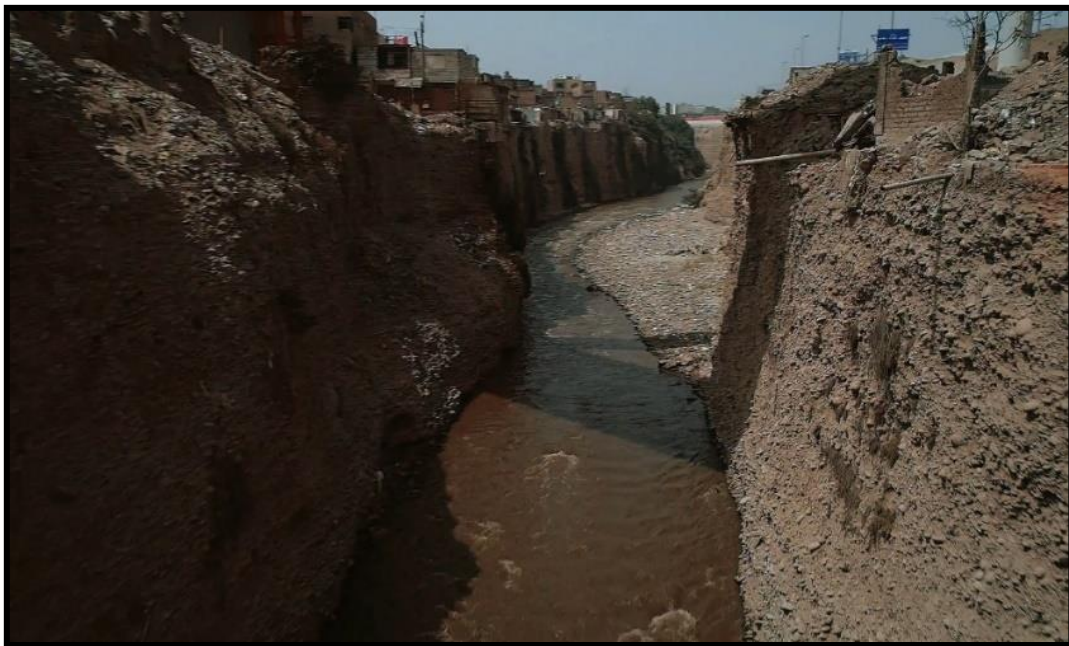
Figura 14. Vista aguas abajo – Rugosidad del cauce natural. Fuente: Fotografía propia.
