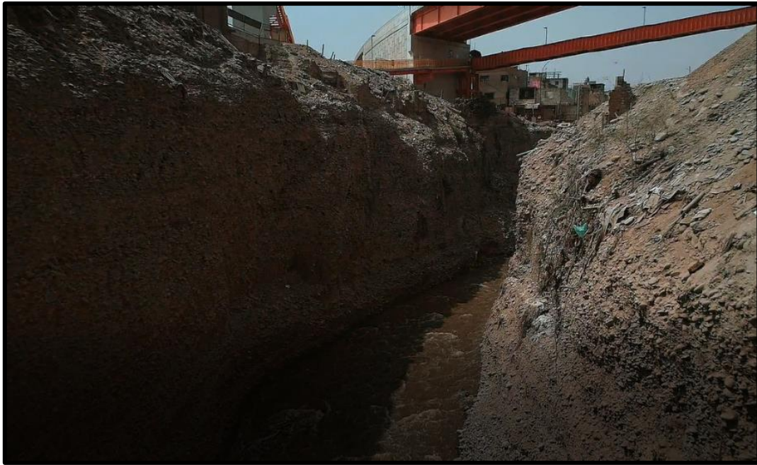
Figura 13. Vista aguas arriba – Rugosidad del cauce natural. Fuente: Fotografía propia.
