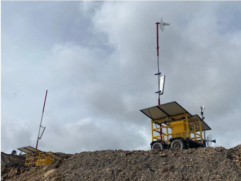
**Figura 37** Carritos móviles repetidoras el Tajo.
