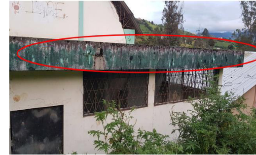
Figura 17. Falla tipo parapeto que se puede desplomarse
