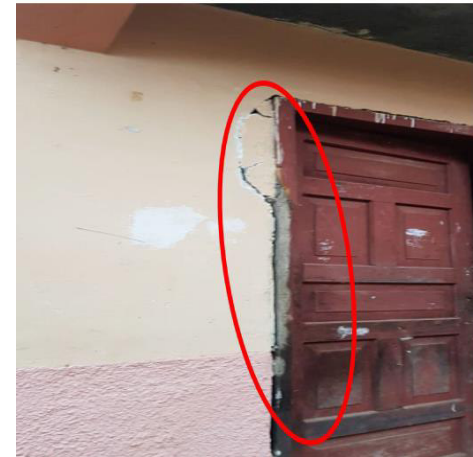
Figura 13. Falla de tipo revestimiento e irregularidad en planta
