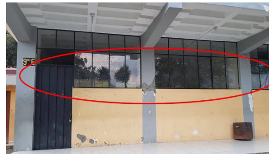
Figura 19. Se identifica una “falla de tipo revestimiento”
