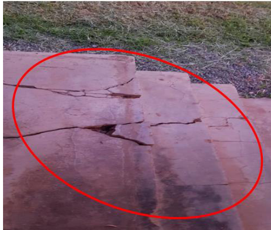
Figura 13. Falla de tipo revestimiento e irregularidad en planta
