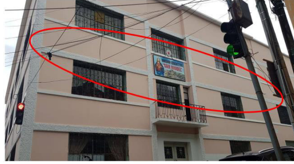
Figura 17. Falla tipo parapeto que se puede desplomarse
