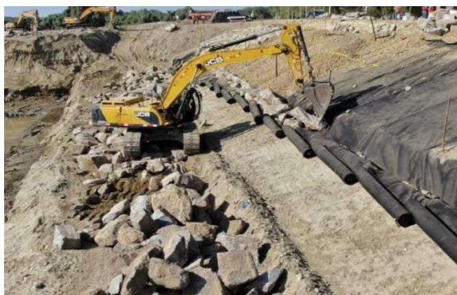
Fotografía 3. Obra de protección ante inundaciones
