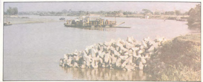
Este es uno de los espigones del río Sinú. Fue elaborado por la comunidad del corregimiento del Río Nuevo, en el Municipio de Valencia, una de las zonas más afectadas con la emergencia invernal.
