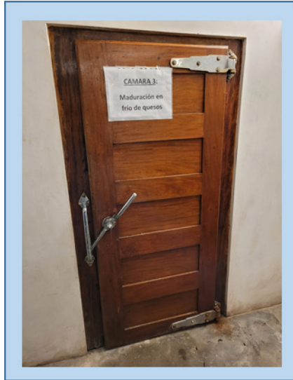
Figura 12: Cámara frigorífica de maduración en frío de quesos de la planta piloto del curso de Agroindustrias.
