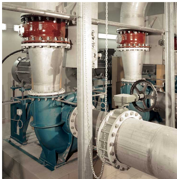
Figura 1.13: Bombas de cámara seca y eje horizontal (fuente: https://bit.ly/3yC3jDc )
