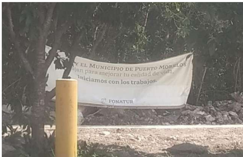
Figura 5. Información sobre inicio de la obra por parte del municipio y FONATUR
