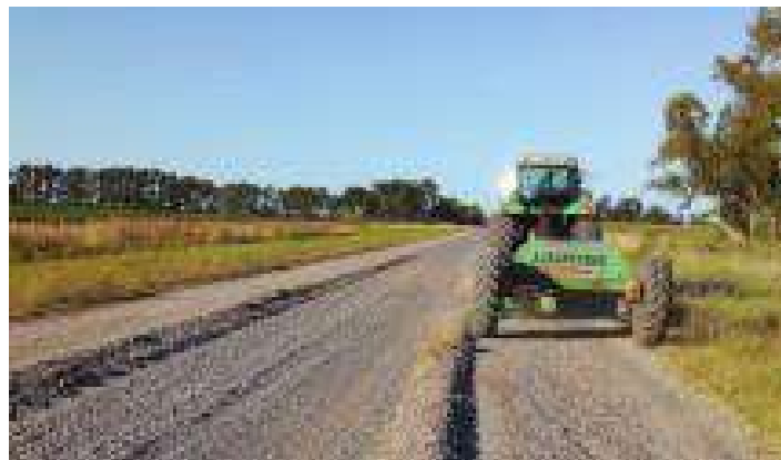
Figura 2: Arreglo mejorado de caminos en Carlos Beguerie
