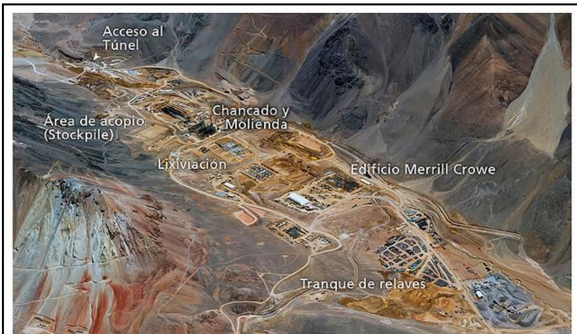
Anexo 24. Foto: Imagen aérea de la planta de procesos del complejo Pascua Lama en el sector argentino. Fuente: Barrick, 2013.
