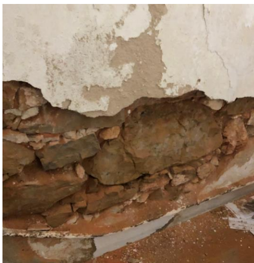
Figura 4.6. Exemplo de alvenaria de pedra ordinária presente no complexo de edifícios do Quarteirão Cultural de Loulé
