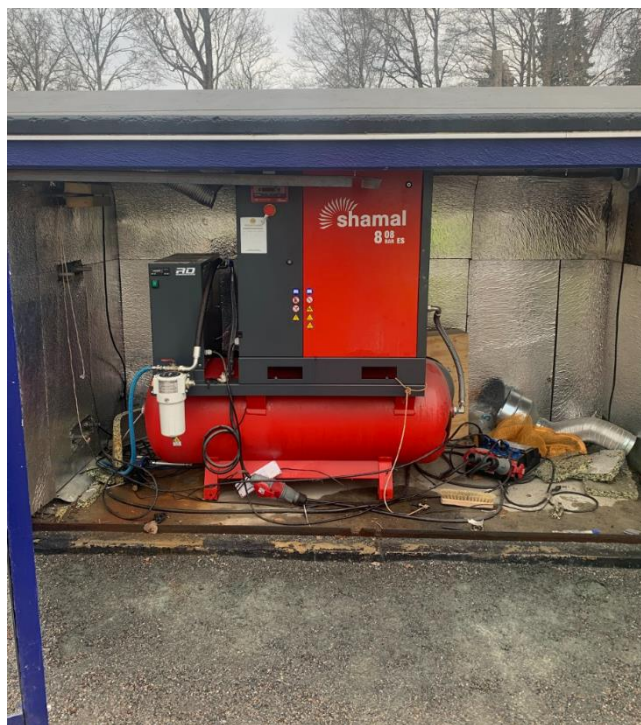
Figur 8. Kompressorn - Storm 8-8-270 ES 10.0Hk 8Bar 270l/tank 1250l/min med kyltork. Illustration är fotograferad av Tilda Andersson.
