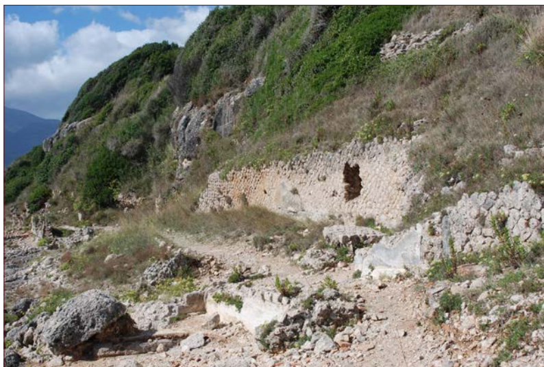
Fig. 77: Villa di Gianola (Scauri, Lt), sostruzioni in opera reticolata (foto di Michele Stefanile).
