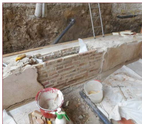
Fig. 68: Settore produttivo. Ripristino delle mancanze murarie. Riproposizione dei paramenti.
