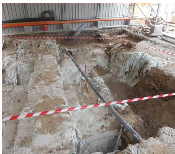
Fig. 52: Settore produttivo. Situazione durante l'eliminazione dell'interro produttivo.
