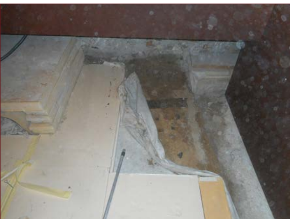
Fig. 27: Rimozione della protezione temporanea.
