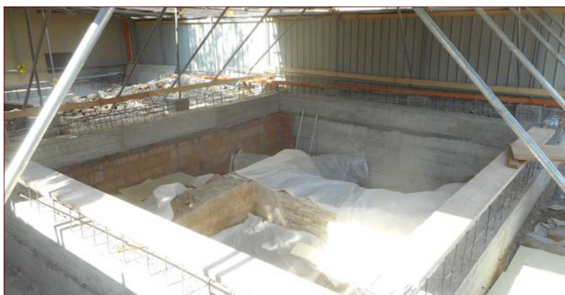
Fig. 72: Settore produttivo. Panoramica generale con struttura di fondazione della teca ultimata.
