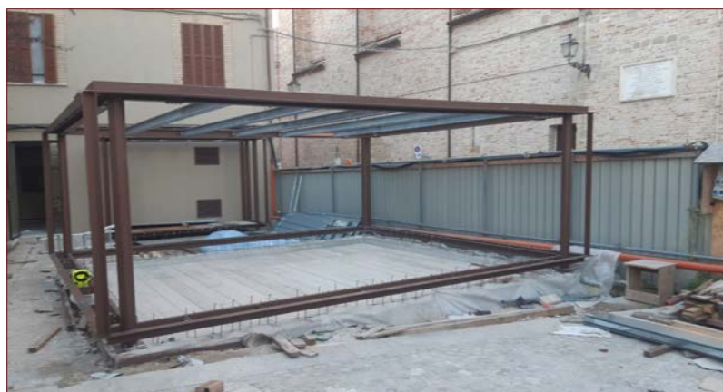
Fig. 73: Area esterna. Protezione con tavolato dell'area degli interventi per il montaggio della teca.
