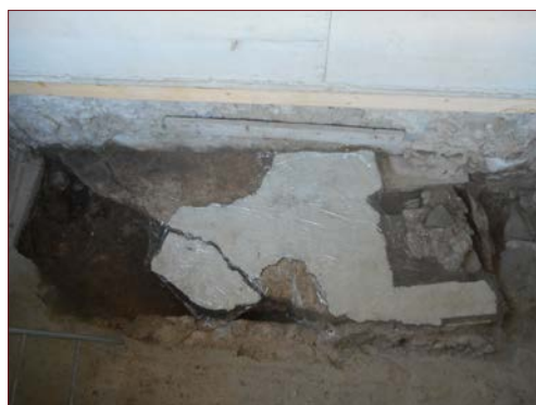
Fig. 62: Vano 6. Fase di pulitura chimica della superficie della pavimentazione in tessellato.
