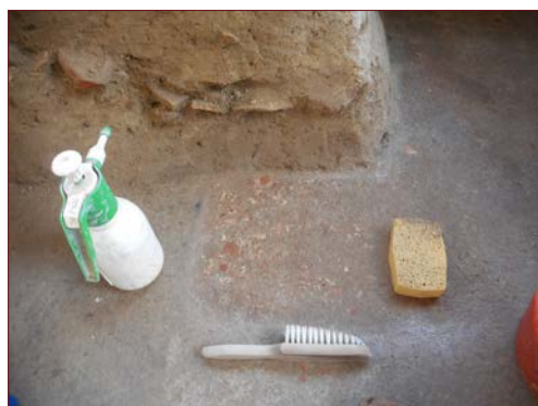
Fig. 61: Settore produttivo. Pulitura delle superfici pavimentali in cocciopesto.
