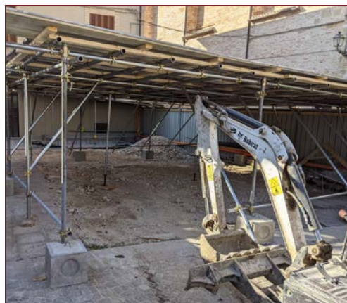
Fig. 57: Area esterna con tettoia protettiva temporanea.
