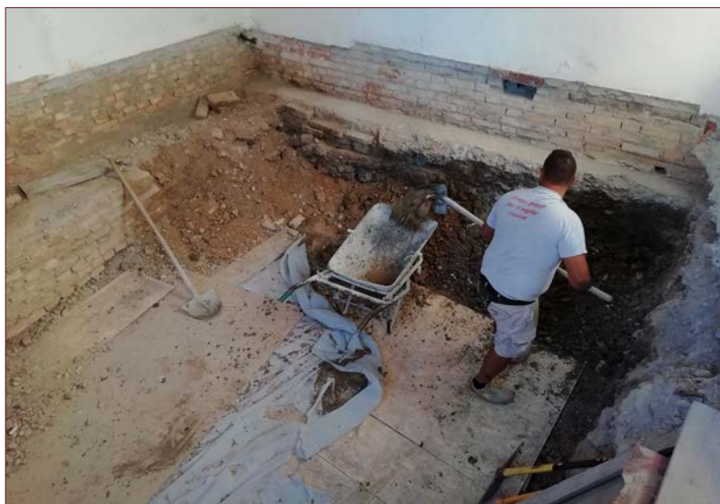
Fig. 26: Protezione provvisoria dell'area di scavo durante i lavori di allestimento delle opere di allestimento.
