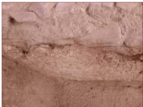
Fig. 60: Settore produttivo. Stuccatura dei bordi dei rivestimenti parietali in cocciopesto.
