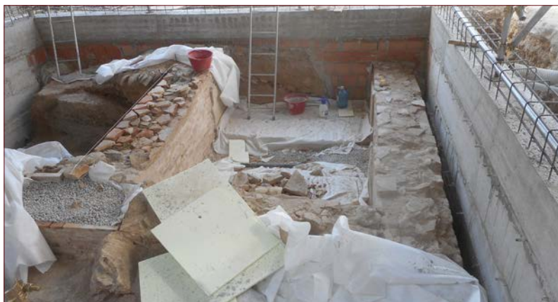
Fig. 71: Settore produttivo. Ripristino delle mancanze murarie. Rifinitura della testa muraria ad imitazione dei tratti originali conservati.
