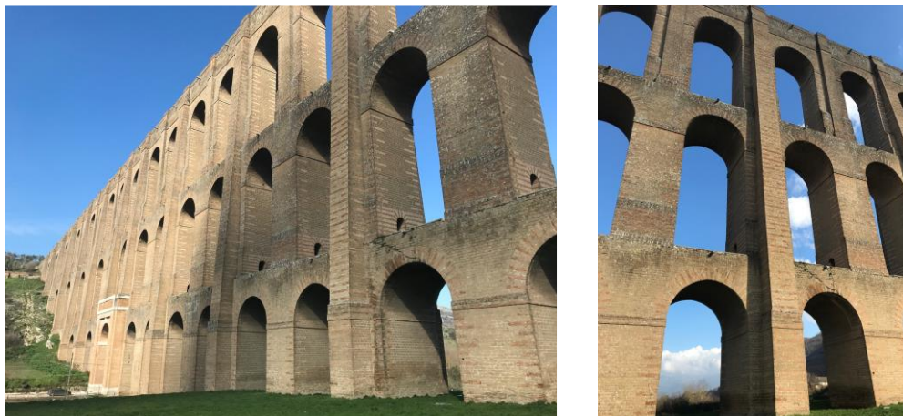
Figure 5.21 - Aqueduct Carolino - “I Ponti della Valle di Maddaloni”.
