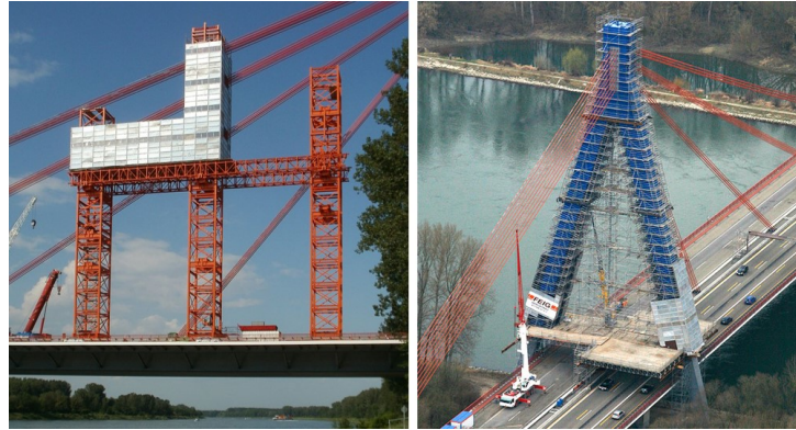
Abbildung 1.2: Sanierungsmaßnahmen an der Rheinbrücke Speyer [7]
