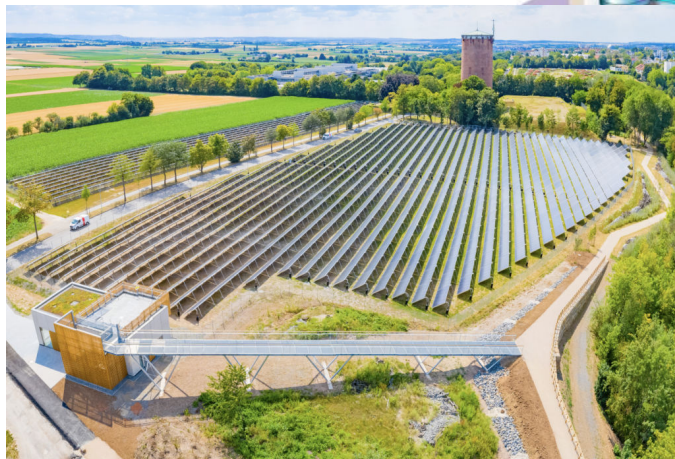
Solarthermieanlage Stadtwerke Ludwigsburg Bild SWLB
