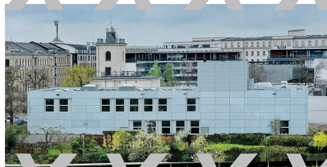
Abb. 1: Das neue Forschungsgebäude des Instituts für Meteorologie der Universität Leipzig (© SIB/Corinna Ködderitzsch).
