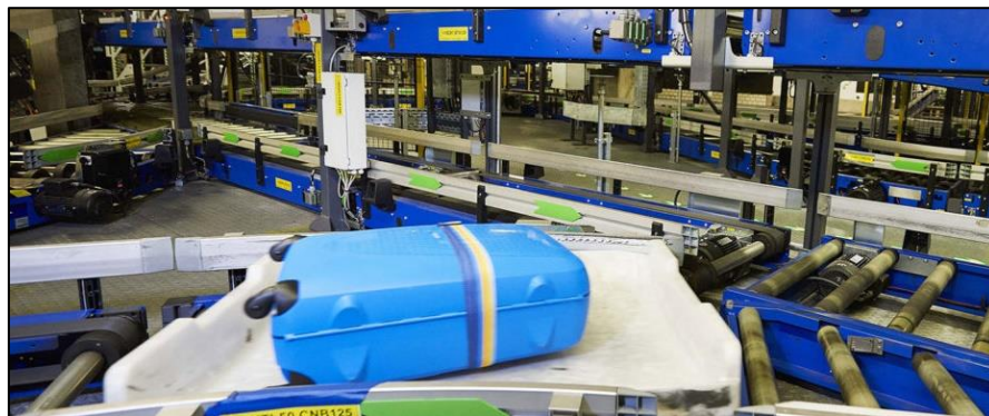
Abbildung 13: Behälterbasierte Gepäckförderung (Quelle: BEUMER Group)
