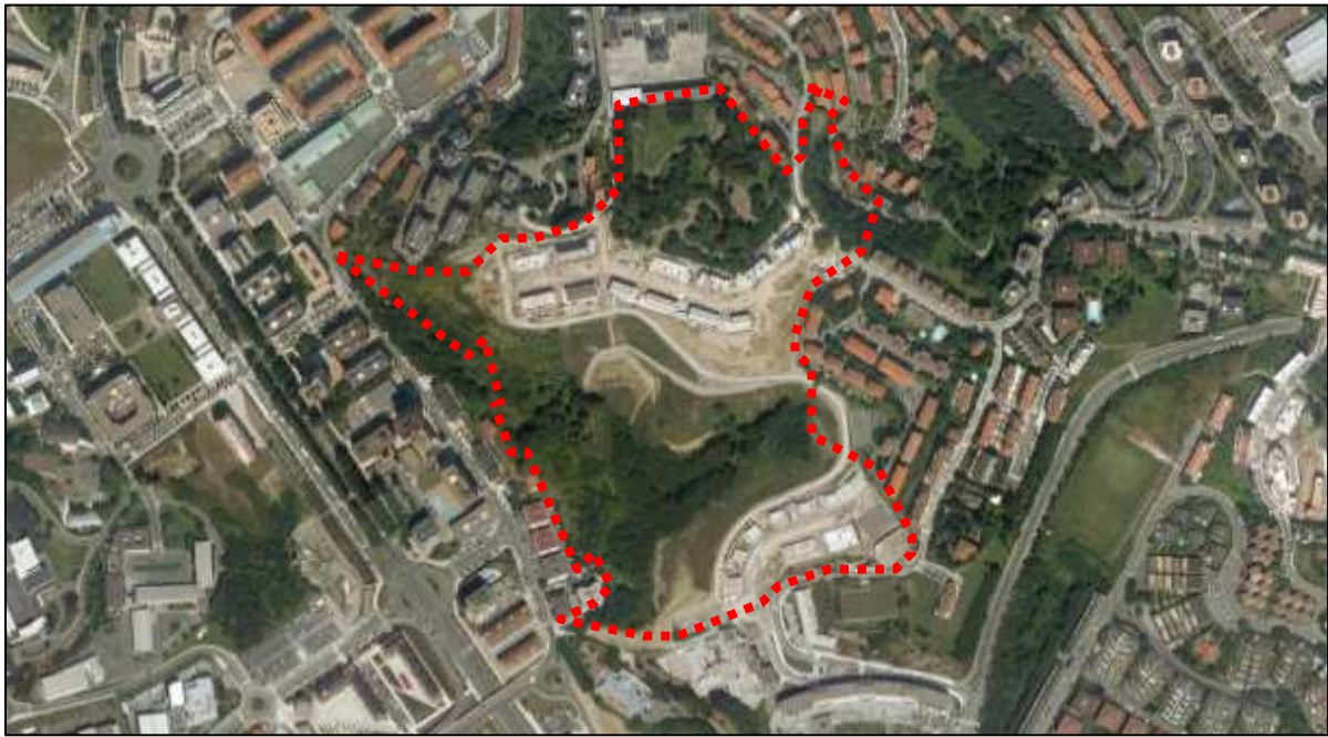
Vista aérea Lugaritz Google maps
