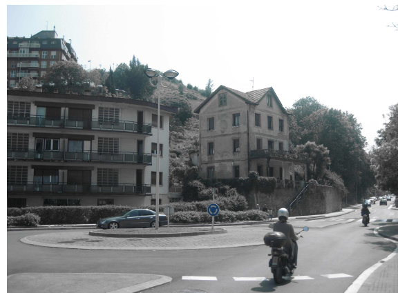
Conexión con lo existente, Avenida de Zarautz
