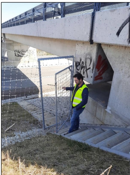
Obr. 23 a, b Kontrola oplocení (na obr. a je zobrazeno chybné osazení branky, nelze plně otevřít proti schodům, na obr. b je vidět chybně provedené zapuštění pletiva, to mělo být v celé výšce svislé a zapuštěné do vrstvy štěrkodrti) (foto autorka DP)
