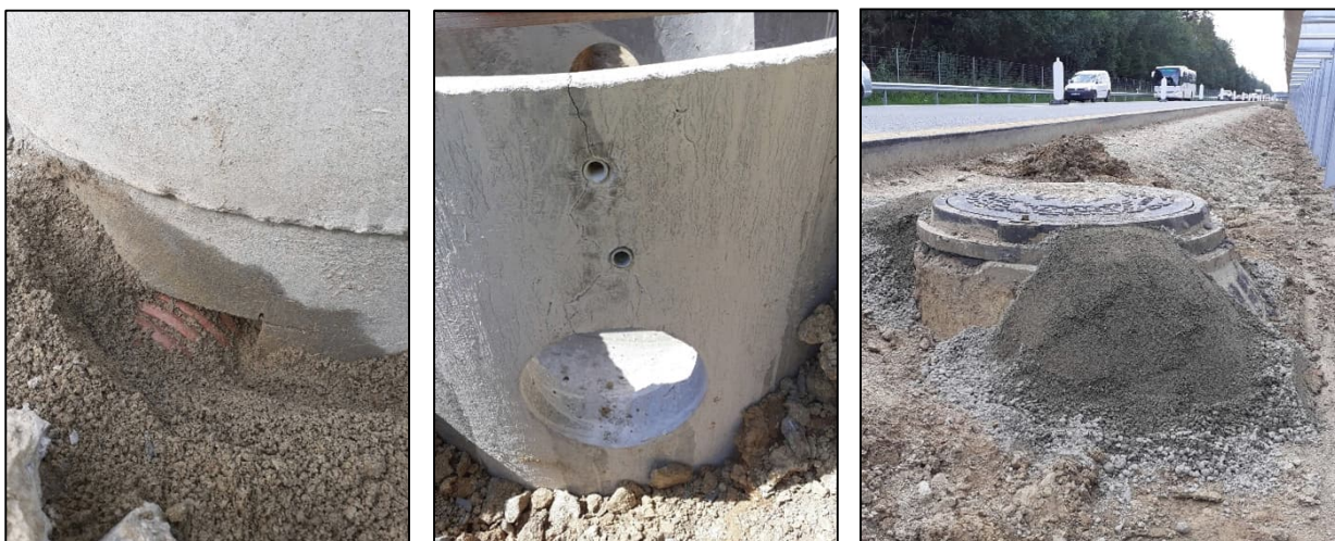
Obr. 18 a, b, c Kontrola zabudovaných výrobků
