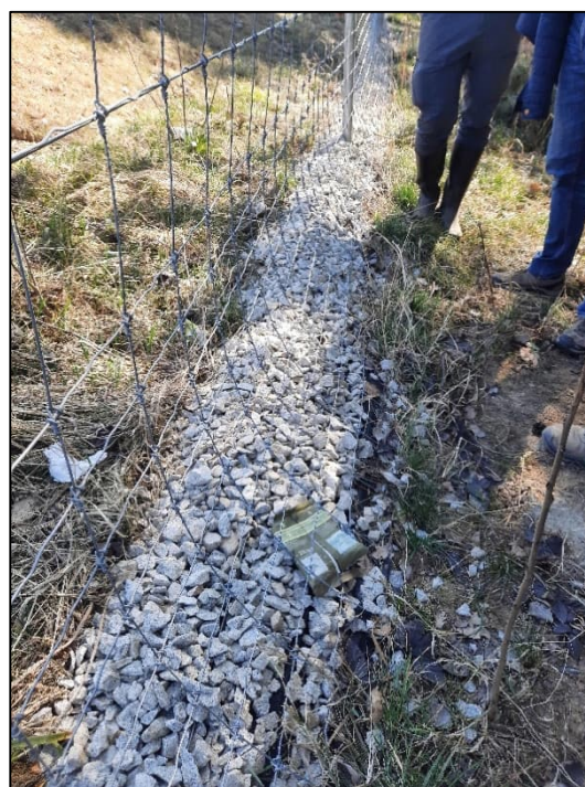
Obr. 23 a, b Kontrola oplocení (na obr. a je zobrazeno chybné osazení branky, nelze plně otevřít proti schodům, na obr. b je vidět chybně provedené zapuštění pletiva, to mělo být v celé výšce svislé a zapuštěné do vrstvy štěrkodrti) (foto autorka DP)
