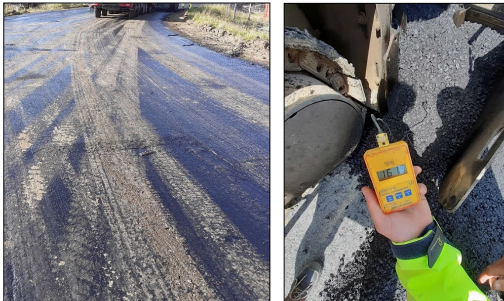
Obr. 21 a, b Kontrola spojovacího postřiku mezi vrstvami AHV, kontrola teploty asfaltu během pokládky (u šneku finišeru dle ČSN) (pozn. na obr. a je vidět špatně provedený spojovací postřik, zřejmě provedený na neočištěnou vrstvu, čímž došlo k nanesení postřiku na kola nákladních aut navážejících asfaltovou směs) (foto autorka DP)
