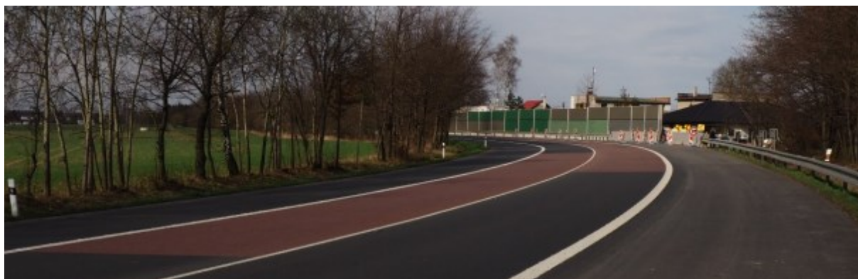
Obrázek 15- Bezpečnostní protismyková úprava ve směrovém oblouku
