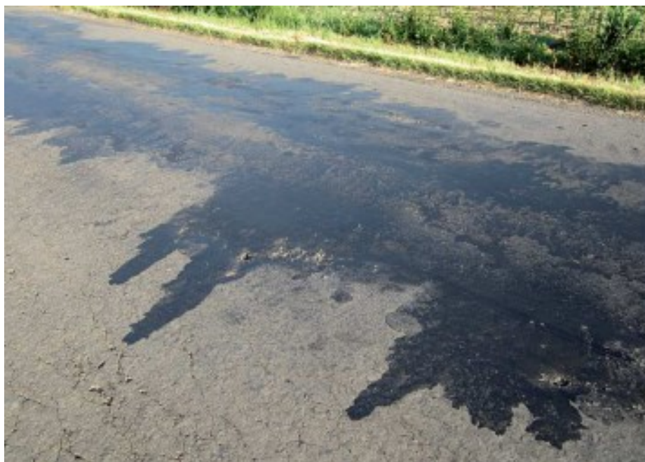
Obrázek 14- pocení asfaltu – ztráta mikrotextury [21]
